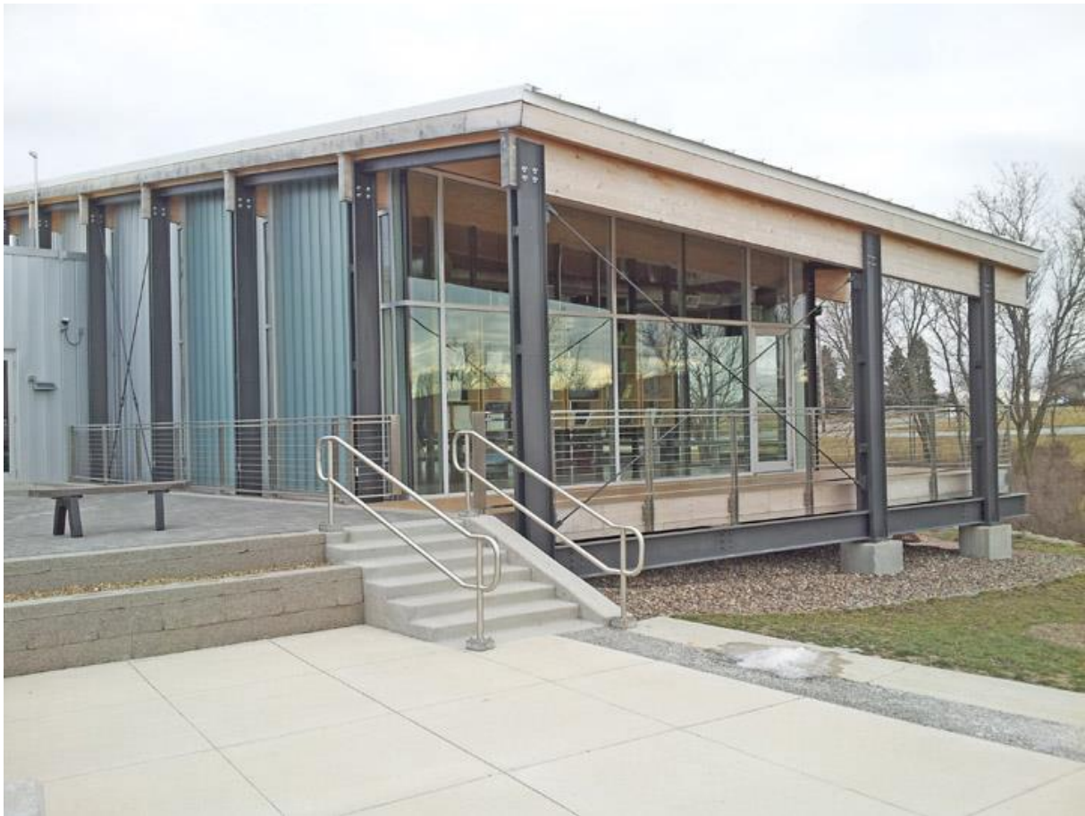
Εικόνα 37: Χώρος Περιβαλλοντικής Εκπαίδευσης στο Κέντρο Ανακύκλωσης East Side Iowa
